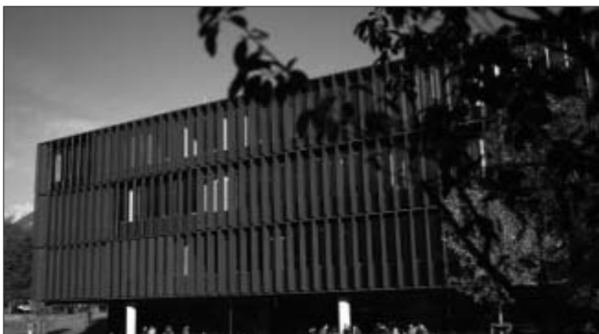
Gelände UMIT in Hall i. Tirol
